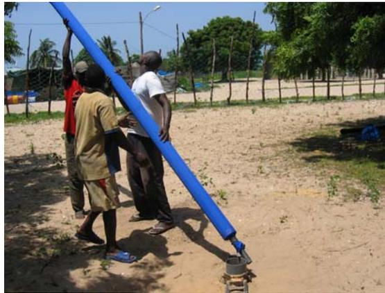
Après l'équipement, on procède à un développement du forage de façon à créer des voies d'eau naturelles au niveau de la crépine : il est souvent réalisé par un pompage d'eau lent et progressif.
