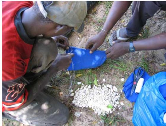
Le tuyau crépiné est alors introduit dans le trou et au niveau de la crépine, un massif filtrant de gravier est réalisé. Le reste du trou est comblé d'argile.
