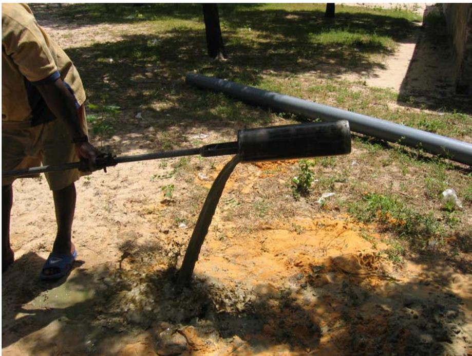
Cet horizon sableux est traversé jusqu'à son bout. Et s'il est d'épaisseur jugée satisfaisante (capable de fournir un débit intéressant), on s'arrête là pour l'équipement. Dans le cas contraire, on peut encore progresser, traverser une seconde couche d'argile avant de retrouver un second aquifère sableux plus intéressant.
